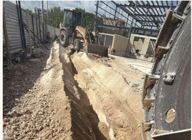
02 • Terracerías y zanjado de alta capacidad
