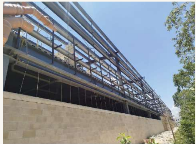
04 • Montaje de estructura metálica y cubiertas
