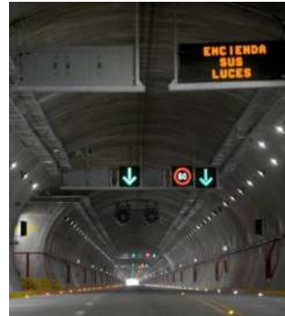
Acatúnel · Entronque Brisamar
