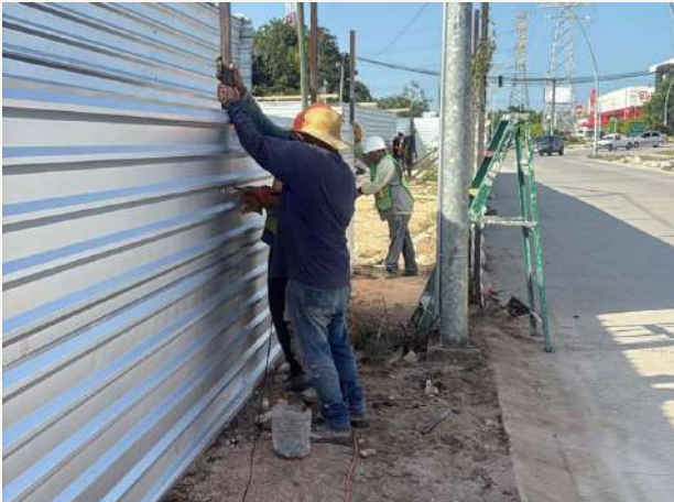
01 • Obras preliminares y confinamiento
