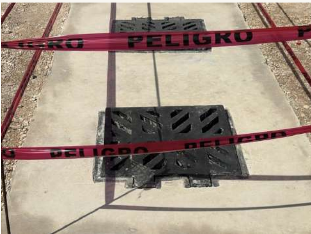
03 • Instalaciones hidrosanitarias y drenaje pluvial
